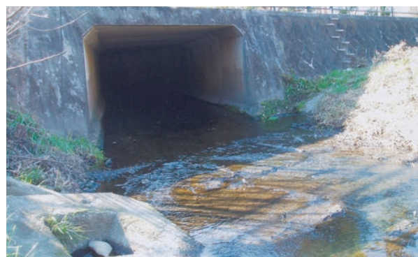
KT-3 黒目川中流 中橋下流右岸（楊柳川出口）
