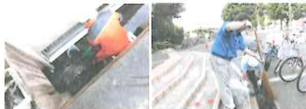
大雨時の排水詰り防止(側溝清掃)
