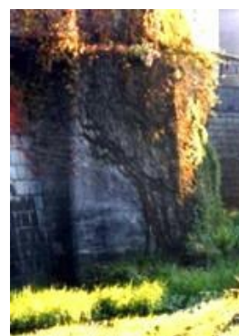
現在も残る橋台（右）
