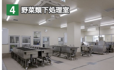
除去が難しいとされる虫や毛髪に異物除去効果のある洗浄機を導入。シンク類はフットバルブ方式で、手で作業しながら足操作で給水・給湯をコントロールできます。
