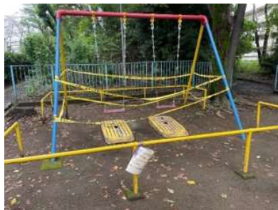
出典：東久留米市 HP より 【下里公園 遊具の老朽化】
