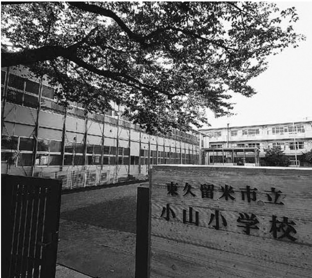
市立小山小学校 新設南門(右手前)と仮設校舎(左奥)
