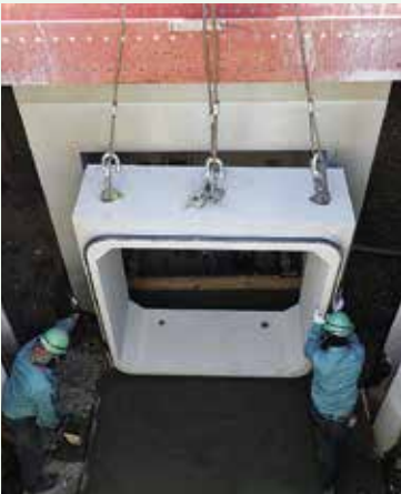
冠水対策に向けた整備
