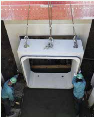
冠水対策に向けた整備
