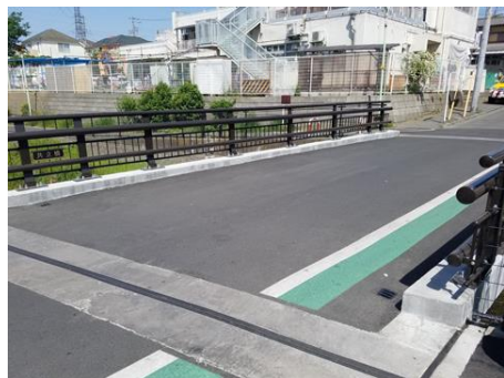
落合川にかかる共立橋（28年度に改修）
