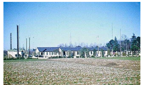
写真3 久留米村内の施設とアンテナ 戦後は一時米軍の通信施設となりました。 1951年・Jim Carpenter氏撮影(許諾済)
