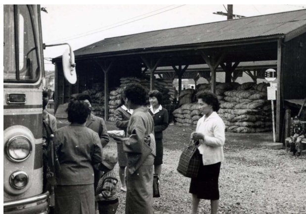
写真4 駅前広場から見た貨物専用ホーム 木造屋根があり、積まれた物資が見える。1963年（昭和38年）撮影
