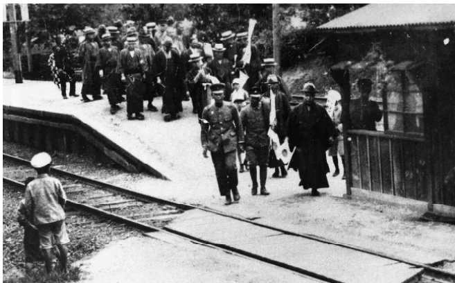
ホームと待避線・列車取扱所 1932年（昭和7年）撮影
