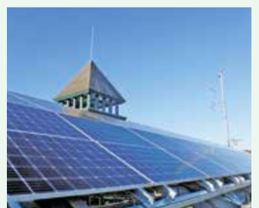
市役所本庁舎屋上の太陽光パネル
