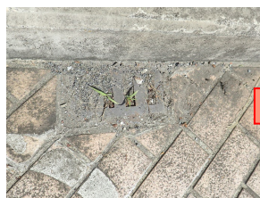
排水ます（清掃前）
