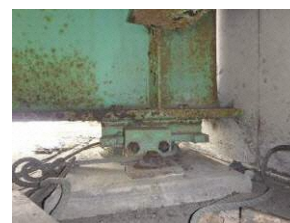
桁端部の腐食
