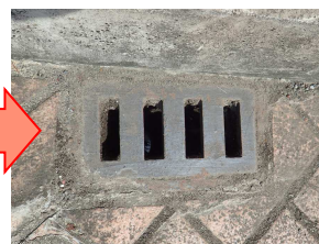
排水ます（清掃後）
