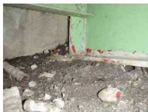
橋座部土砂溜まり
