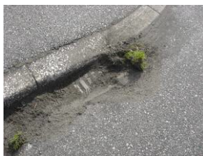
排水ます土砂詰まり
