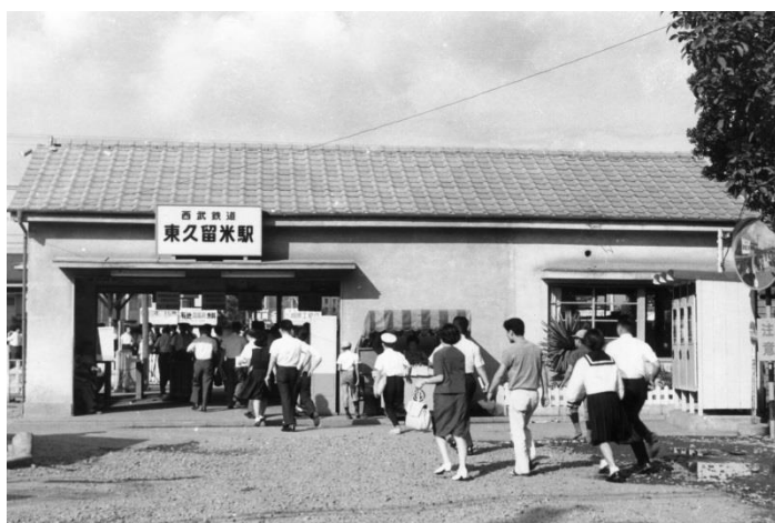
東久留米駅駅舎（昭和 44 年）
