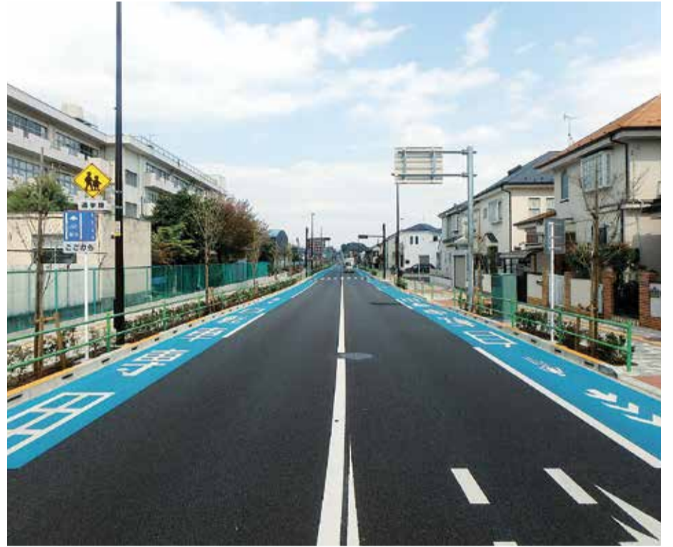
無電柱化された道路(神宝町一丁目)
