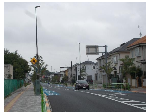
無電柱化された都市計画道路
