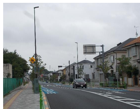
無電柱化された都市計画道路
