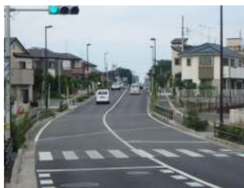
無電柱化された都市計画道路
