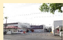
野火止一丁目の工場
