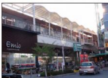
東久留米駅北口連絡通路
