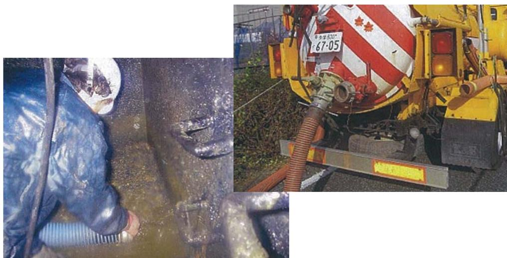
図 2-19 伏越しマンホールの清掃状況
