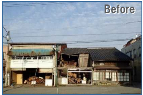
空き家の除却
