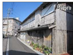
空き家の除却
