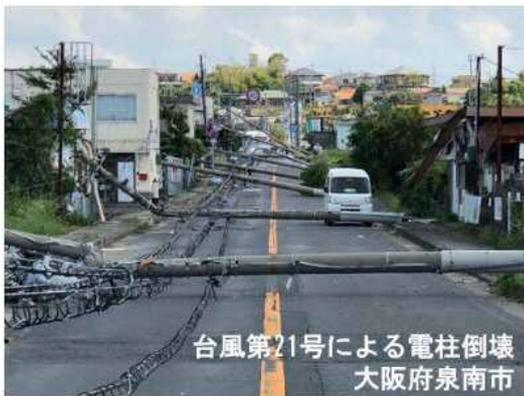
図 1-1 電柱倒壊による通行障害
