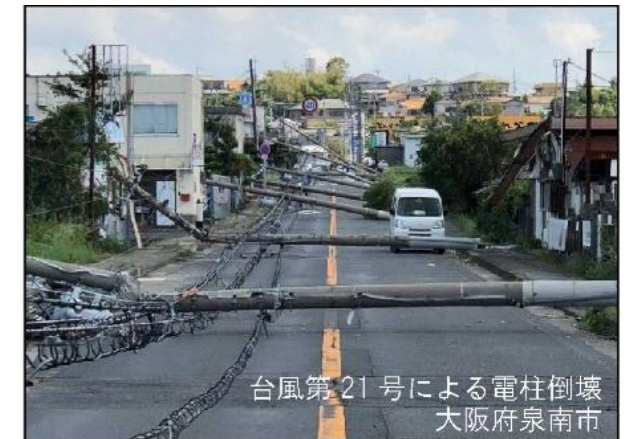
台風第 21 号による電柱倒壊 大阪府泉南市 台風第 21 号（平成 30 年 9 月） 出典：国土交通省 HP より http://www.mlit.go.jp/report/press/road01_hh_001086.html
