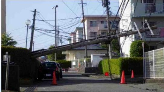
図：熊本地震による電柱の倒壊
