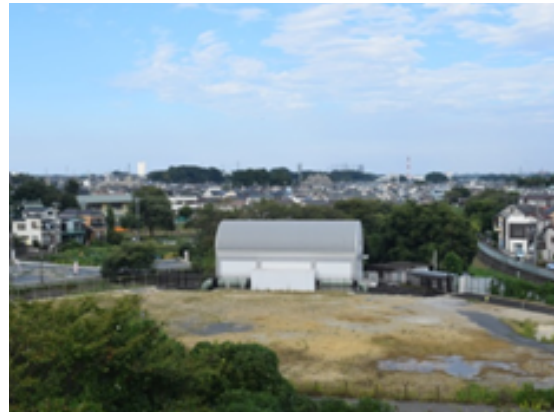
黒目川黒目橋調節池工事
