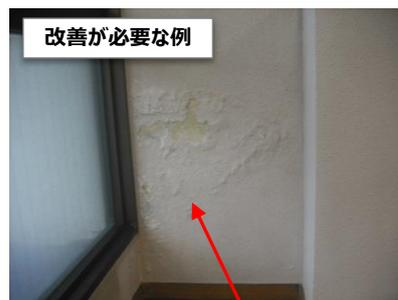
仕上げ材の浮き、剥離
