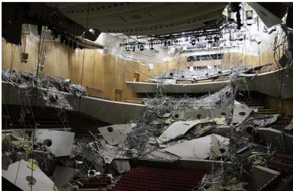
平成23年3月11日に発生した東日本大震災の直後、音楽ホールの吊り天井が脱落した例。
