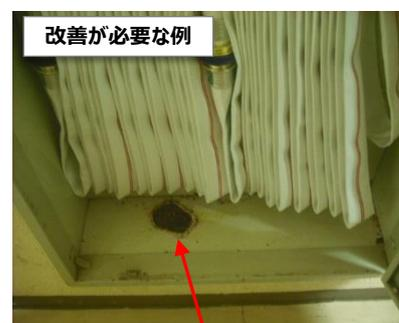
消火栓ボックスの腐食
