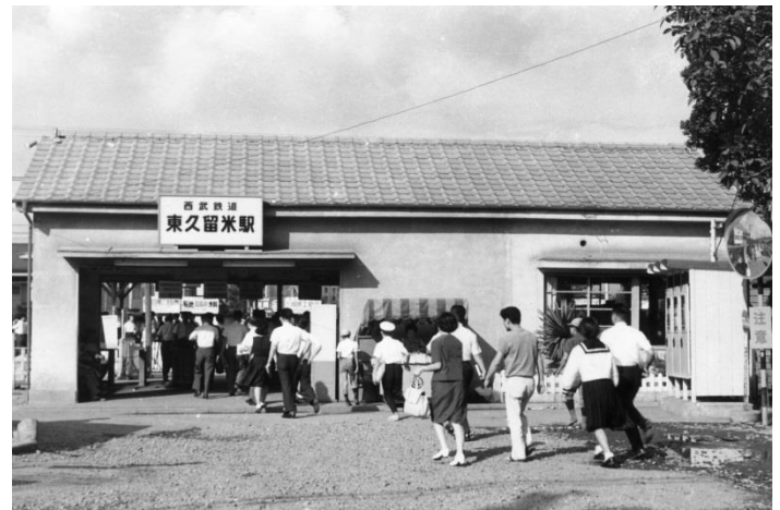
東久留米駅駅舎（昭和 44 年）
