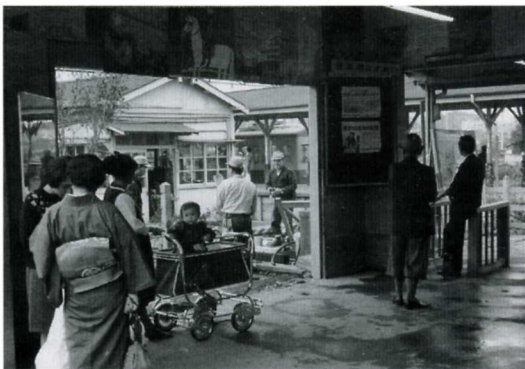
駅舎の出入り口を新設 昭和43年(1968) 滝山団地ができるなど乗降客が増え、東側の壁を抜いた。
