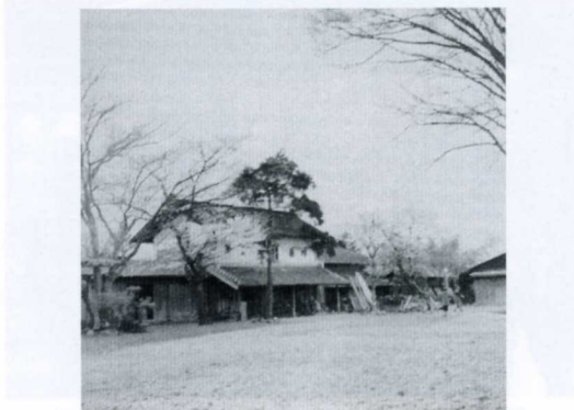
駅前の倉庫 昭和41年(1966) 東本町 運送業「丸通」の倉庫があり桜がきれいだったという。
