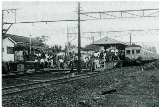
▲昭和44年 東久留米駅 ホームはまだひとつ。乗客は線路 を渡って改札口へ向かう。
