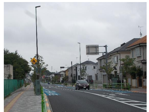
無電柱化された都市計画道路
