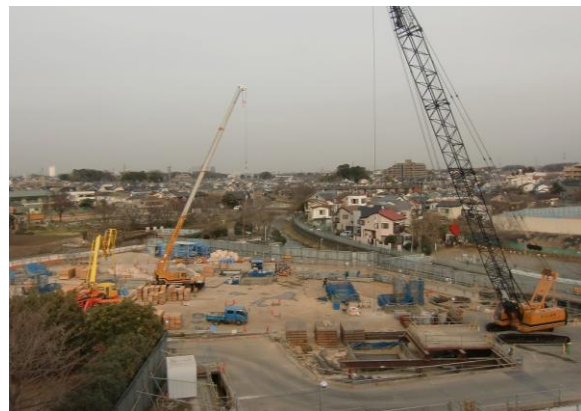
黒目橋調節池工事
