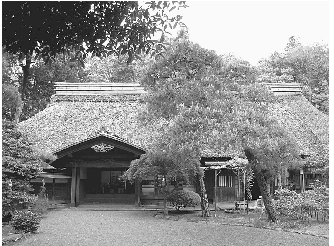
国登録有形文化財(建造物)の村野家住宅「主屋」
