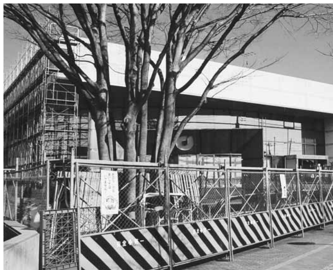
外装補修、空調設備改修が行われた中央公民館
