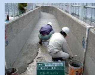
ポリマーセメントモルタルによる補修
