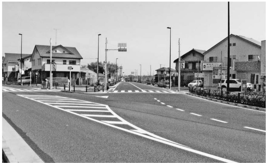
3月30日に開通した3・4・19号線 (小金井街道との分岐点)
