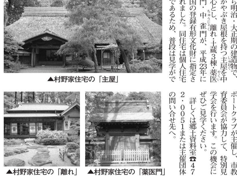
▲村野家住宅の「主屋」 ▲村野家住宅の「離れ」 ▲村野家住宅の「薬医門」
