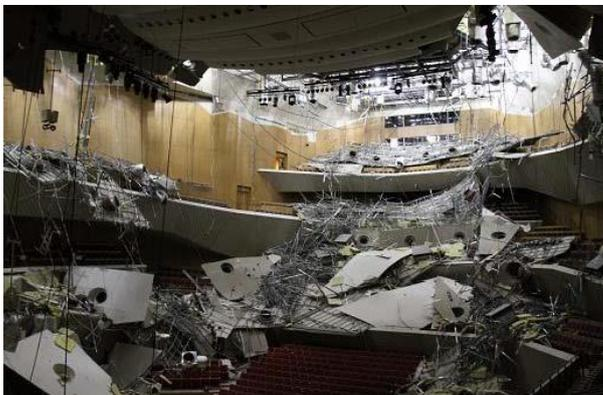
平成23年3月11日に発生した東日本大震災の直後、音楽ホールの吊り天井が脱落した例。
