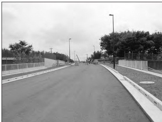
整備中の道路
