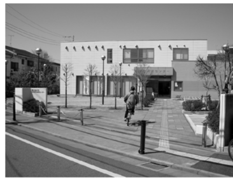
連続した視覚障害者誘導用ブロック (中央町地区センター)
