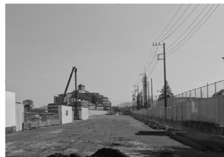
活力拠点 (事業中の南沢五丁目地区)
