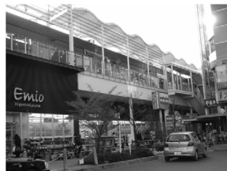
東久留米駅北口連絡通路
