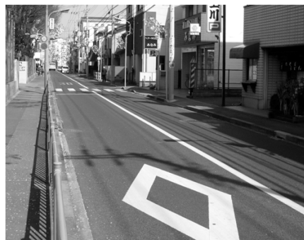
道路の保水性舗装（五小通り）
