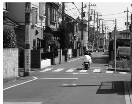
交差点の高輝度舗装（南町通り）
