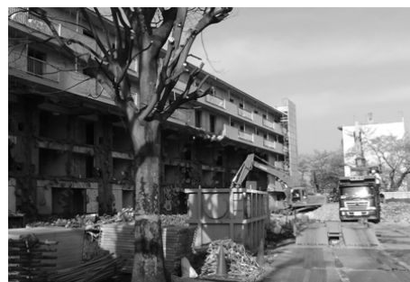
まちづくり重点地区 (上の原一丁目の解体中の住宅団地)
