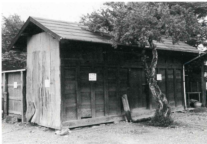
▲穀櫃の全景（解体前、南より）
