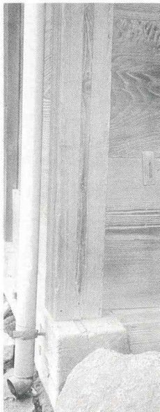
なかじき ▲中仕切りのための 柱の溝
