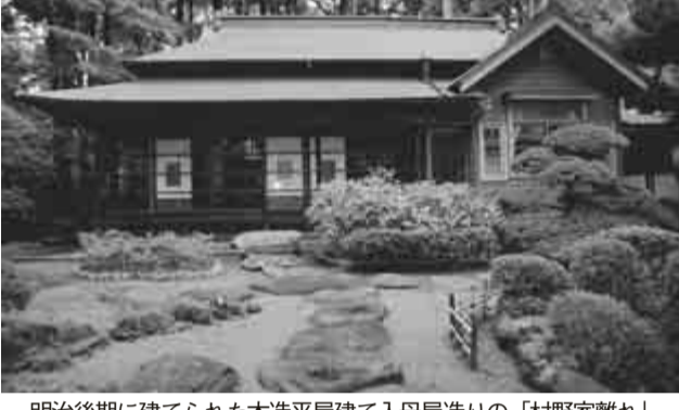
明治後期に建てられた木造平屋建て入母屋造りの「村野家離れ」
