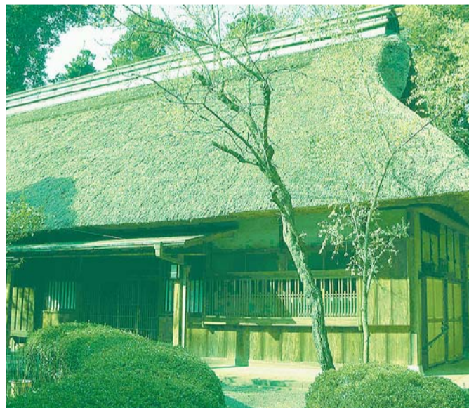
かやぶき屋根が美しい村野家住宅の「主屋」
