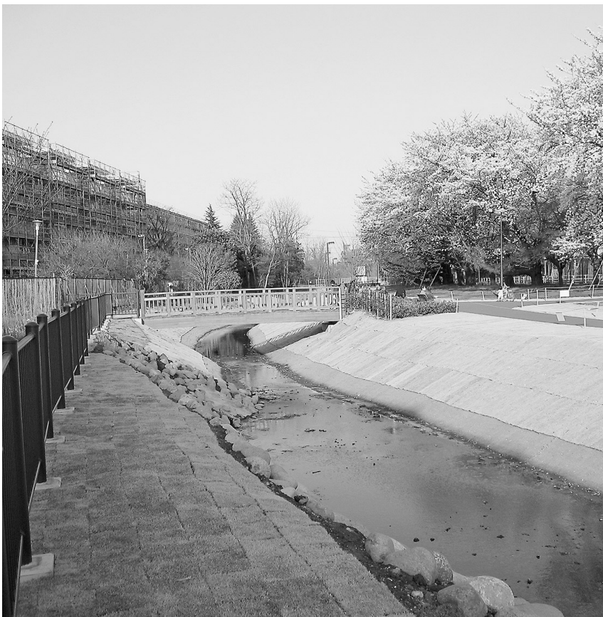
一部オープン黒目川親水広場(久留米西団地付近)
